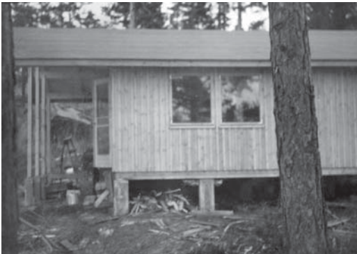
Kesämökki pystyssä. Kuva lienee otettu keväällä 1958 ennen kuin savupiipun muurausta oli aloitettu.
